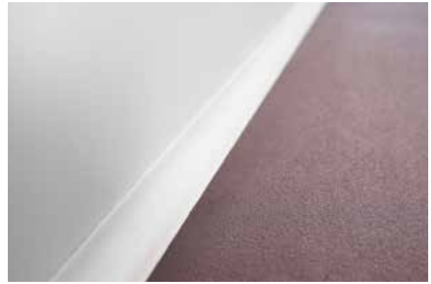
Angoli raggati Per garantire la massima igiene e facilità di pulizia.
